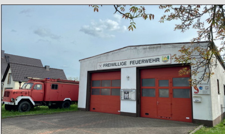
Neubau Feuerwehr Klöden
